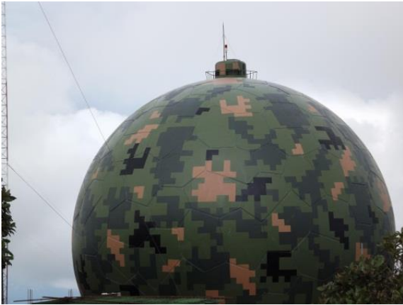
图表27：S 波段相控阵天气雷达
