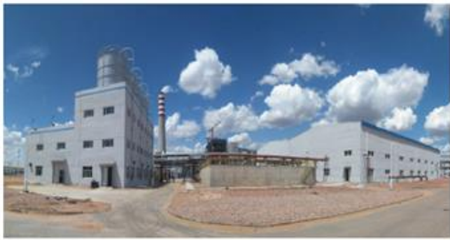
图 24：中天合创废水处理及回用装置 EPC 项目
