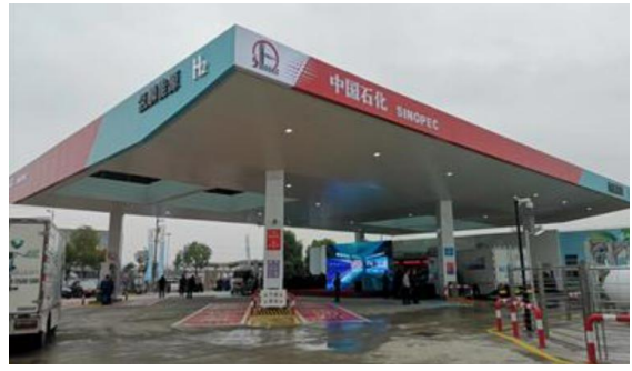
图 19：上海第一座油氢合建站
