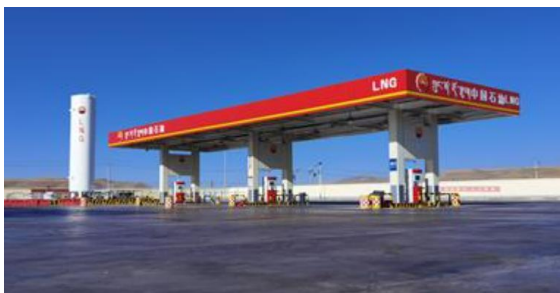
图 16：中石化青海 LNG 加注站
