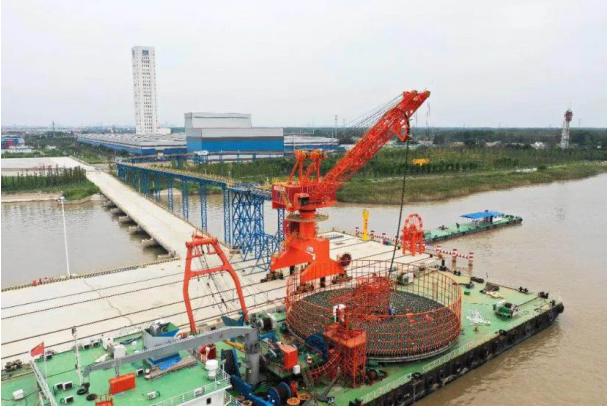
图 26. 公司位于扬州的海缆码头
