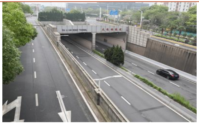
图 22: 上海大连路隧道
