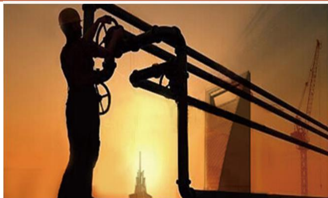
图 14: 上海中心燃气排管工程
