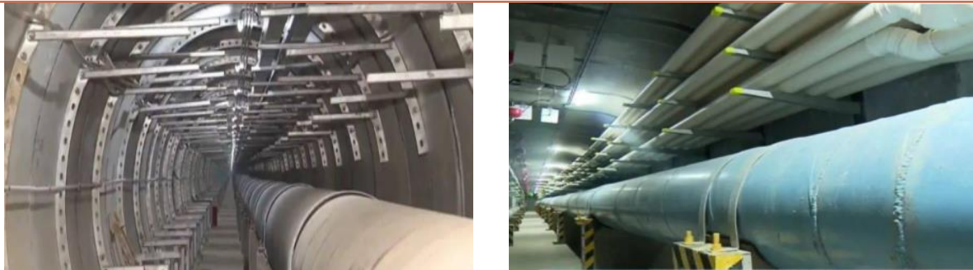
图 17：厦门翔安南路综合管廊
